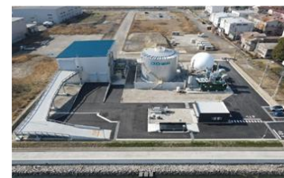
バイオガス発電
