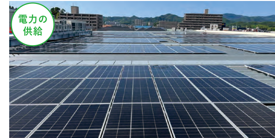
340KWの大規模太陽光パネル(オンサイトPPAによる自家消費)
